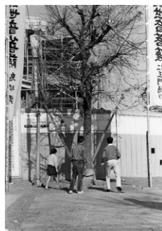
59-24. [宝生院再建工事告知看板] 17.3×12.1cm
