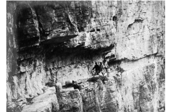
60. 櫻井一郎(亞東印画協会) (1893-1928) SAKURAI Ichiro 《絶壁を通ずる索道(三峡)》 A Path Excavated through the Precipitous Cliff, Sanhsia 1926 / 2017年 複写プリント、g.s.p. 25.4×30.5cm
